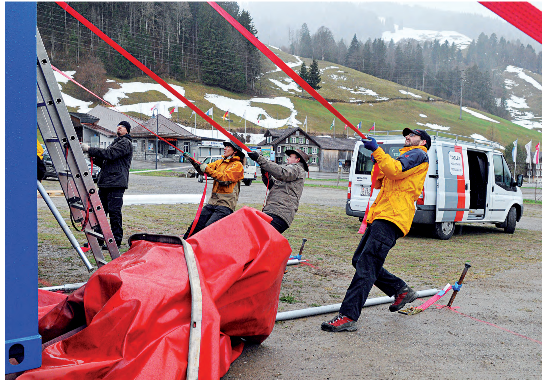
Hau ruck, hau ruck!: Die Blache des Zeltdachs muss über die beiden Container gezogen werden, bevor die Rondellstangen aufgestellt werden können.
