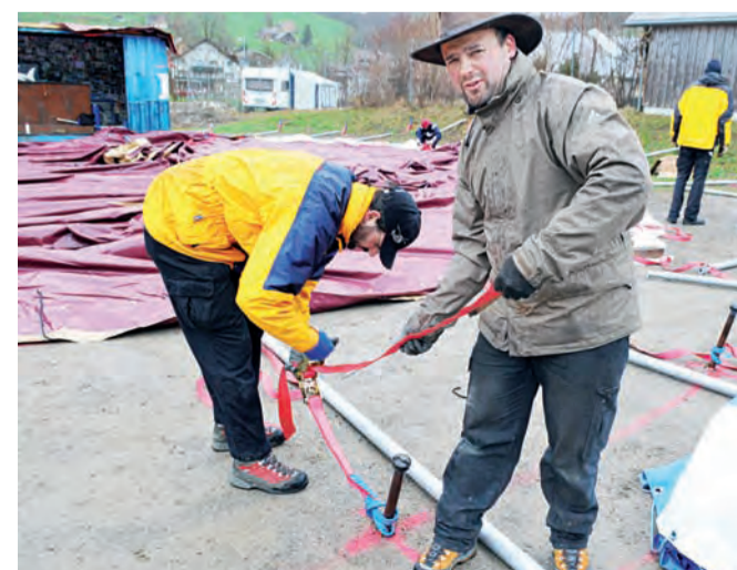
Zeltdach ist ausgebreitet: Nun werden die Spannsätze an den Erdankern vorbereitet.
