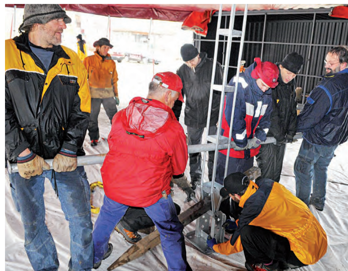
Mit vereinten Kräften II: Ein Zeltmast wird angehoben und zwecks Ausgleichung der Niveauunterschiede mit Holz unterlegt.
