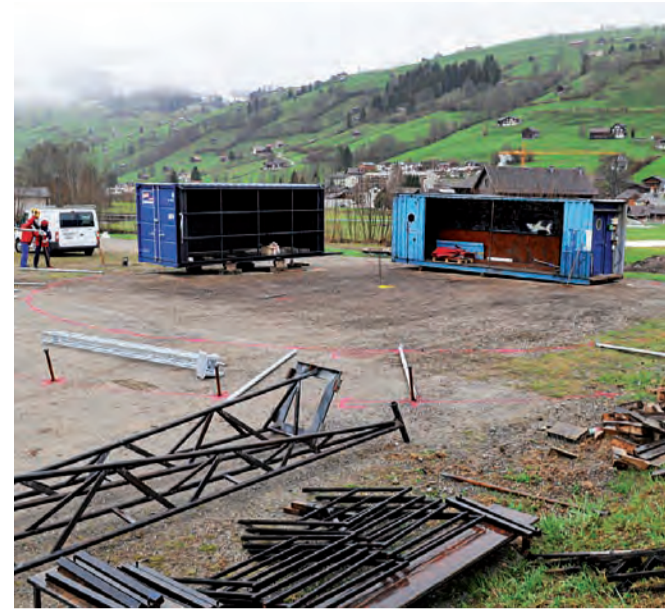
Bühnen- und Barcontainer stehen bereit: Darum herum wird in den nächsten sechs Stunden das Zelt aufgebaut.
